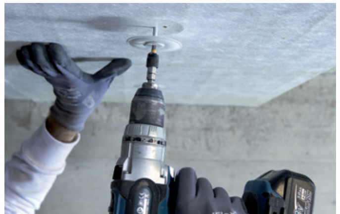
Stap 2: zeer efficiënte thermische isolatie door middel van een extra ROCKWOOL isolatieplaat
