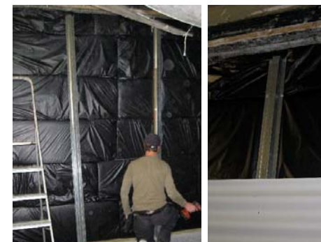
omega profielen t.b.v. "sinus"-beplating
